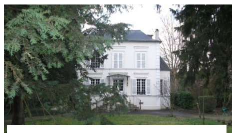
Maison de maître avenue de Rigny
