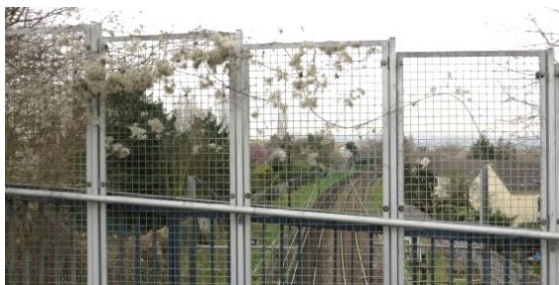
Perspective à mettre en valeur, rue Léon Menu (avec et sans grillage), Source : Even conseil
