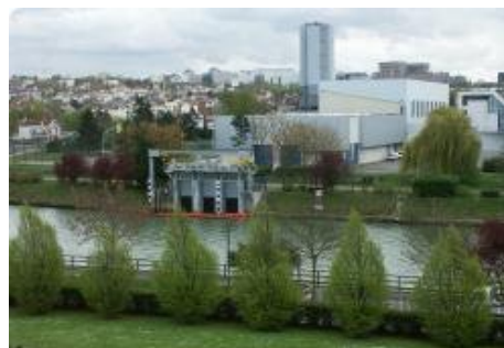
Usine de Neuilly-sur-Marne. Source : SEDIF
