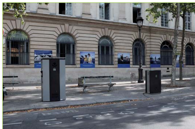
Réseau de bornes de recharge électriques Belib'
