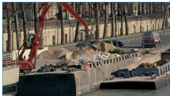
Transports par péniche de déchets industriels issus de démolitions d'immeubles, Quai de seine à Paris Bercy
