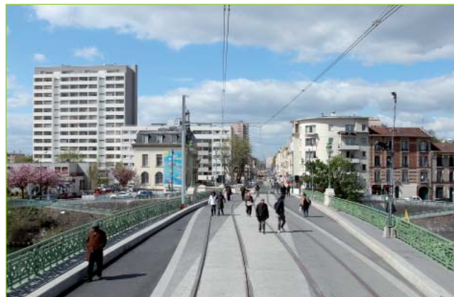
Espace partagé piétons-tramway sur le pont de l'Île-Saint-Denis à proximité de la gare RER de Saint-Denis
